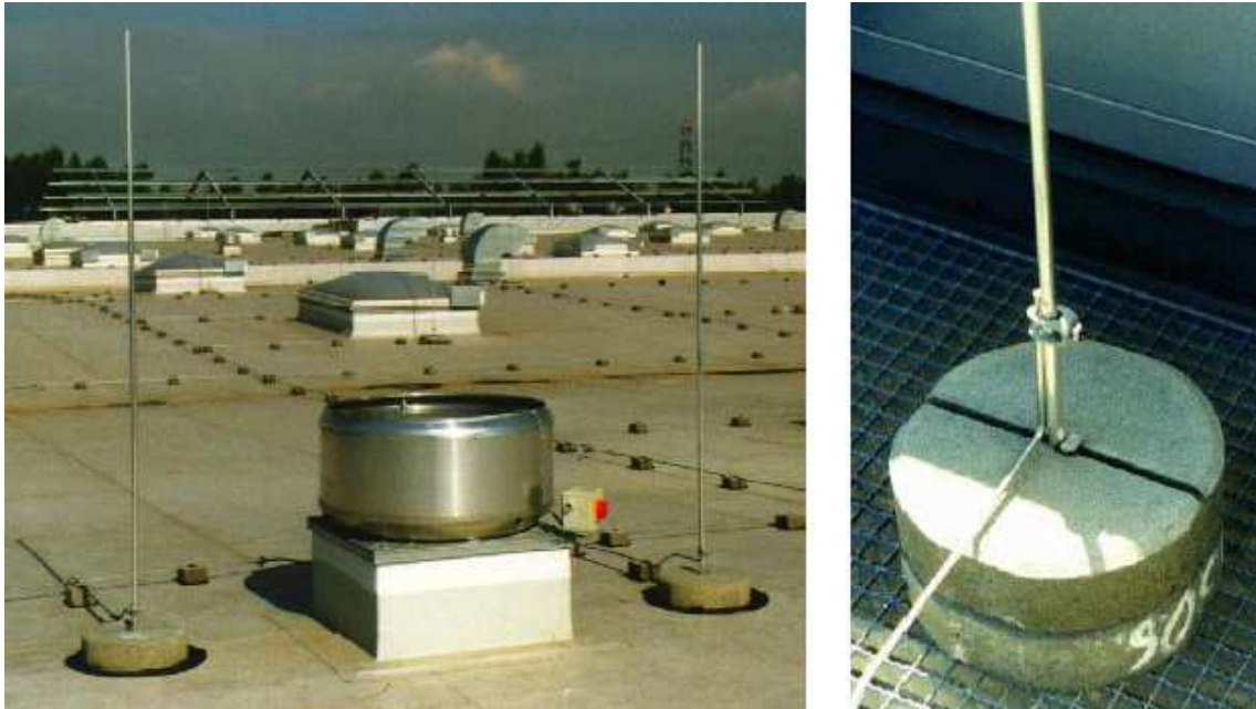
Rys. 3 Zwody pionowe na dachu płaskim
